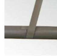
Bringen Sie die Rohrenden unter mittlerem Druck Stoß auf Stoß. So verhindern Sie Spaltenbildung, wenn sich CLIMATUBE® zip bei der ersten Erwärmung fest um die Rohrleitung legt. Für einen perfekten Abschluss, umwickeln Sie die fertigen Stöße mit PVC Klebeband.
