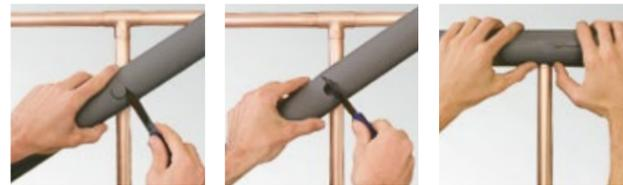
Schneiden Sie zunächst ein Loch in den waagrecht zu verlegenden Rohrmantel – etwas größer als der Durchmesser des abzweigenden Rohres.
