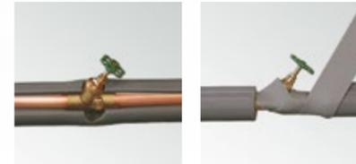
Schneiden Sie ein entsprechend schräges Loch durch den Zipverschluss bzw. durch die Mantelöffnungen. Öffnen und mit einem Messer eine Vertiefung für die Verschraubung auskehlen. Schwer zugängliche Stellen isolieren Sie einfach mit dem PE Wickelband.
